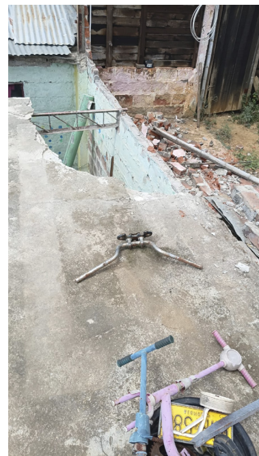
Yolanda. Vía a la granja, camino a la clorinda
